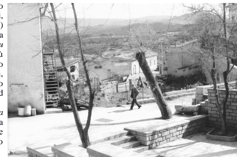
La “colti di lu mulinu” demolita, ripresa dall'alto, Anni Settanta;
